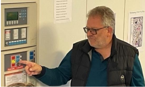
Steiner Hans-Peter/ Brandanlage
